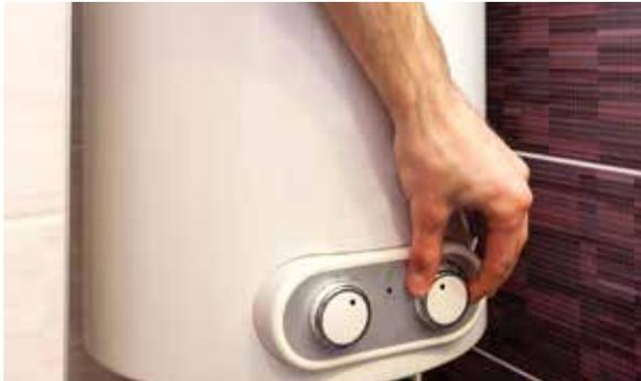
**2 Apaga el piloto** del calentador cuando no lo uses. Si es automático, baja el termostato al mínimo.
